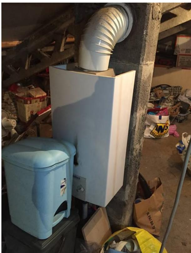
Generatore di calore ACS nel sottotetto
