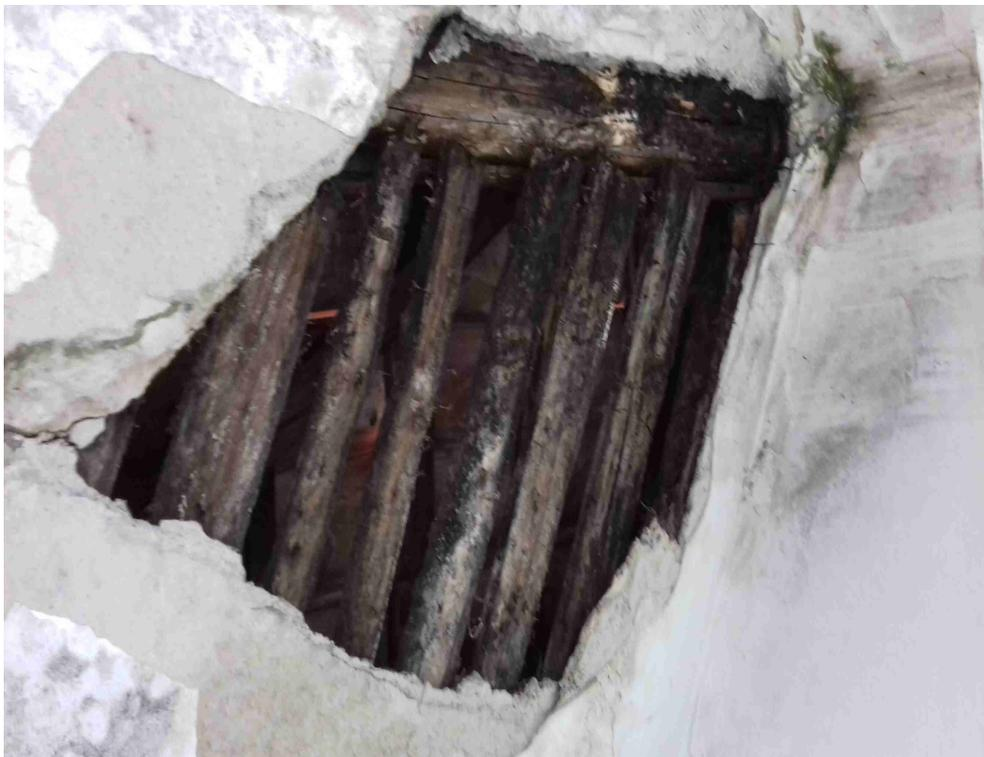
**FOTO N.7 – Particolare contro-soffitto e copertura ammalorati (Vano scala comune)**
