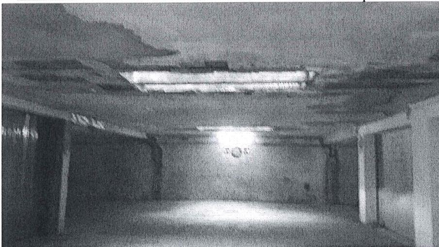
Foto 6 solaio seminterrato con sfondellamento pignatte e ossidazione ferri d'armatura.
